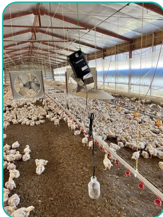
鶏舎での設置例 ミストなどの水分がセンサー部に付着し気化熱で温度が下がらないようにプラスチック素材でカバー
